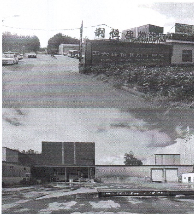
图 1 厂区现场照片
