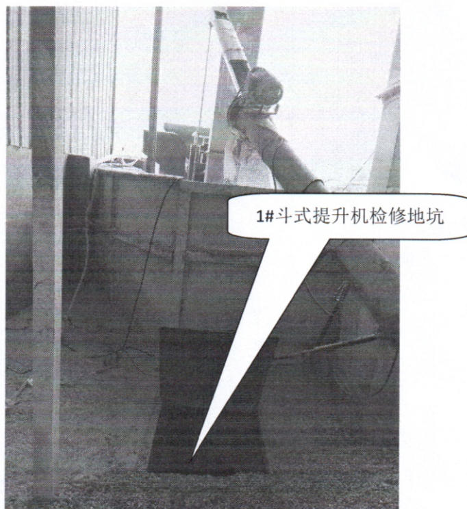
图4 事故发生位置现场照片
